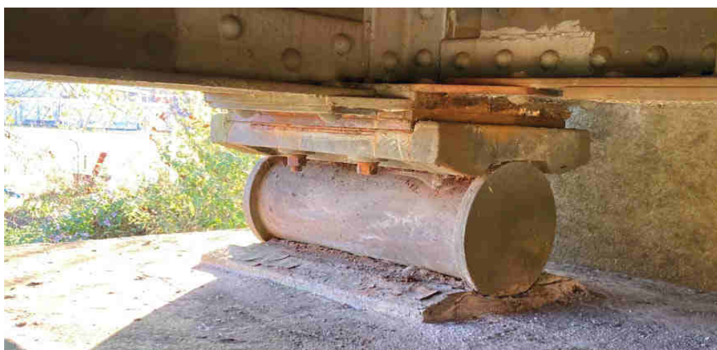
Pohled na posuvné ložisko
