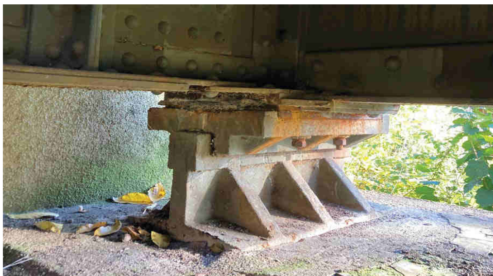
Pohled na pevné ložisko
